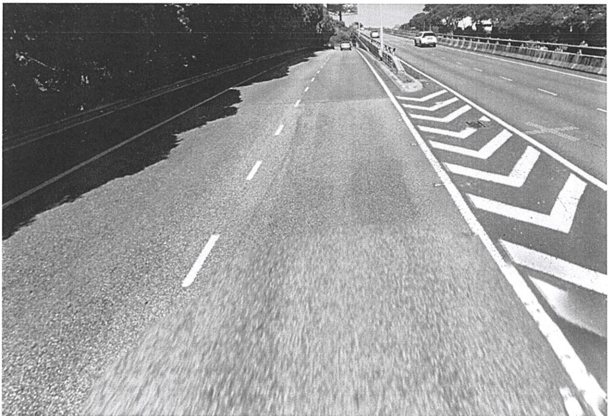
CADANGAN TURAPAN MILL AND PAVE DI SEBAHAGIAN LEBUHRAYA NPE ( KAWASAN SELENGGARA MBSJ) KAWASAN SS 18, SUBANG JAYA, SELANGOR DARUL EHSAN.
