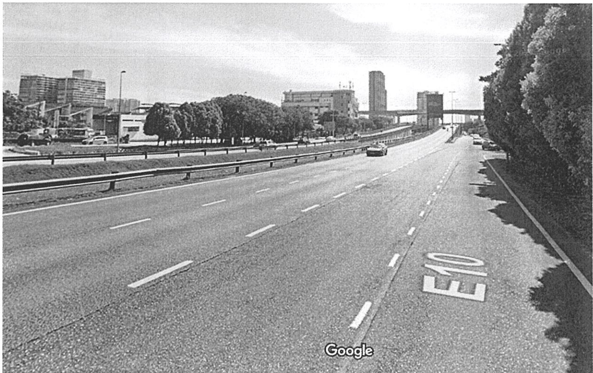
CADANGAN TURAPAN MILL AND PAVE DI SEBAHAGIAN LEBUHRAYA NPE ( KAWASAN SELENGGARA MBSJ) KAWASAN SS 18, SUBANG JAYA, SELANGOR DARUL EHSAN.
