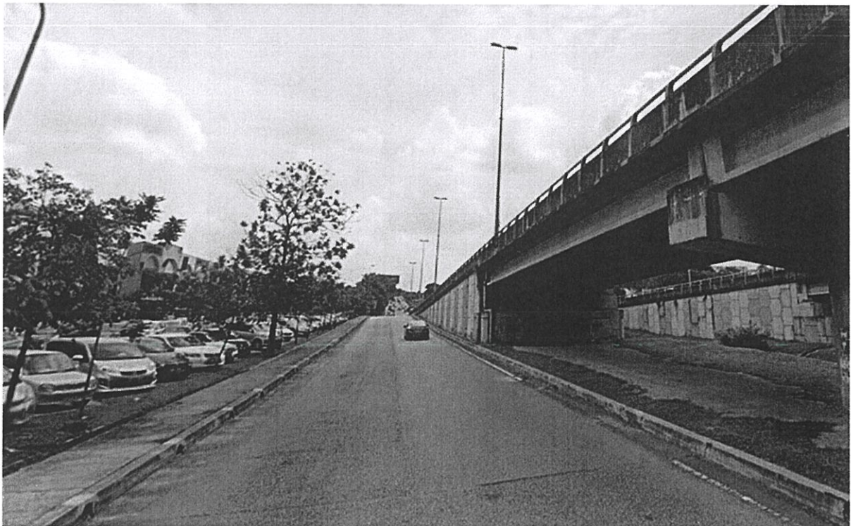
CADANGAN TURAPAN MILL AND PAVE DI SEBAHAGIAN LEBUHRAYA NPE ( KAWASAN SELENGGARA MBSJ) KAWASAN SS 18, SUBANG JAYA, SELANGOR DARUL EHSAN.
